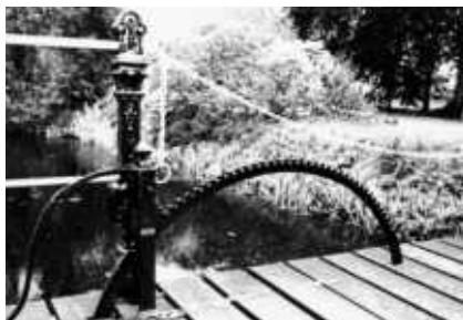
De klapconstructie van de brug
